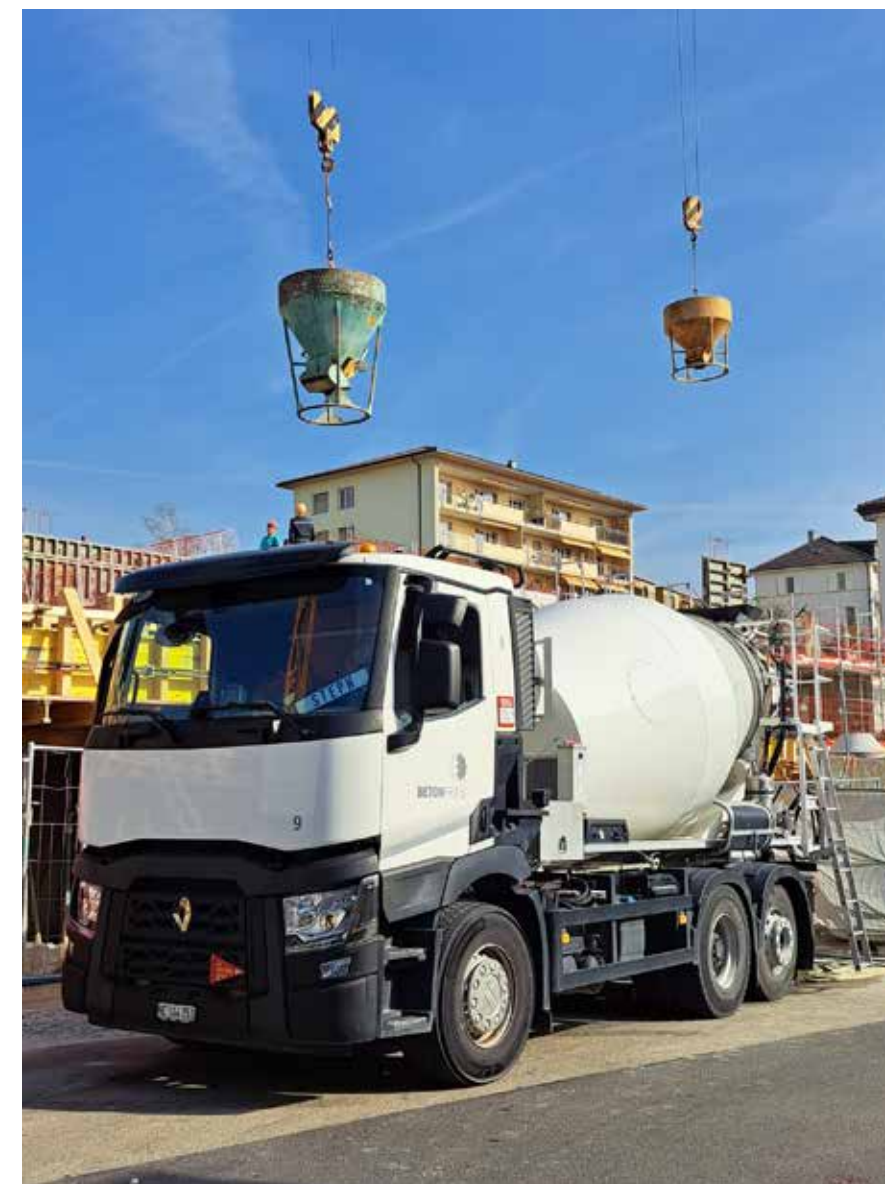
Chantier immeuble Gabriel-Lory 2 Neuchâtel
