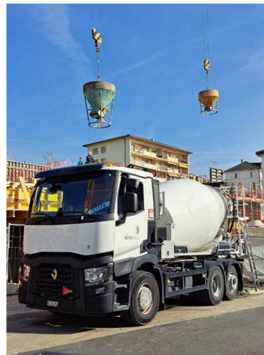
Chantier immeuble Gabriel-Lory 2 Neuchâtel
